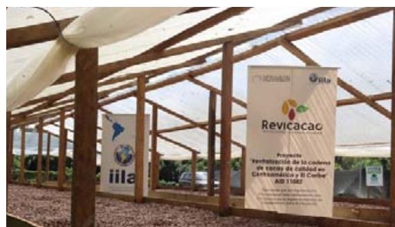
Secador Solar de KATBALPOM ya en uso, con capacidad de 50 quintales de cacao seco.
