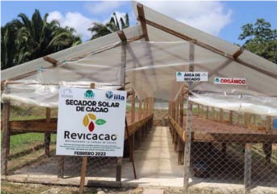
Secador Solar construido para ASODIRP, en Aldea Rocjá Pomtilá, Cobán, Alta Verapaz.
