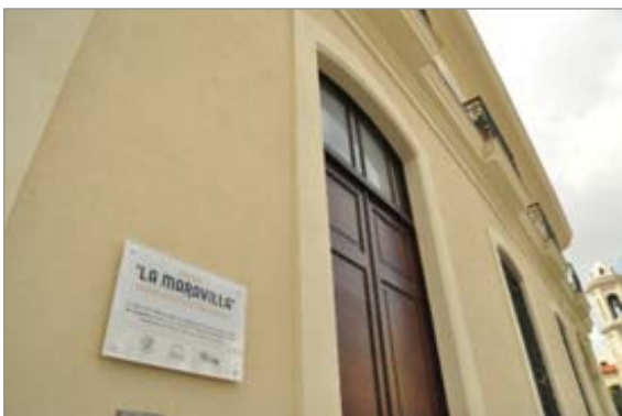
Edificio "La Maravilla", viviendas sociales, Plaza del Cristo, La Habana
