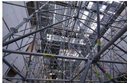
Convento di Santa Clara, lavori
