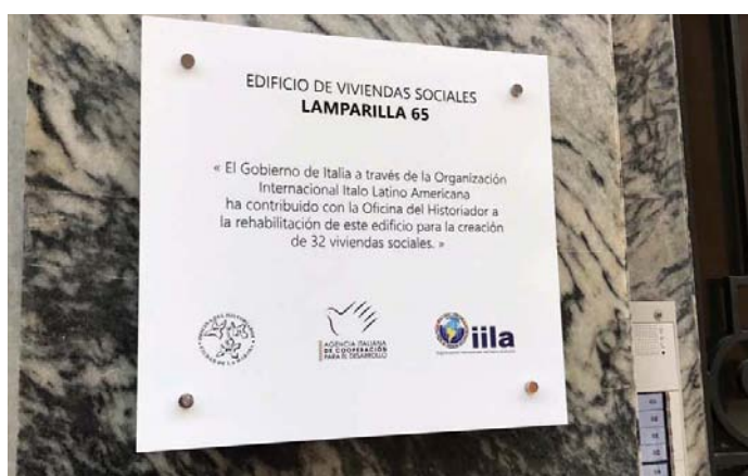
Edificio situato in Calle Lamparillas 65, restaurato e adibito a "viviendas" nell'ambito del Progetto IILA
