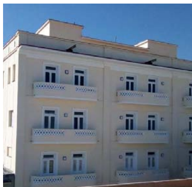
CALLE LAMPARILLA 65: Facciata principale
