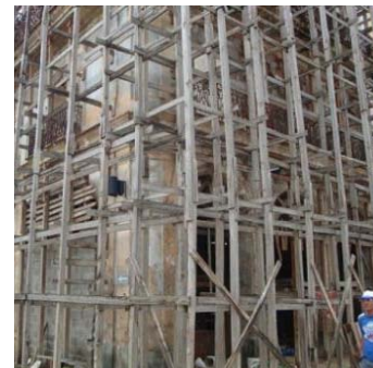
EDIFICIO MARAVILLAS (Villegas 351): Lavori di rafforzamento strutturale
